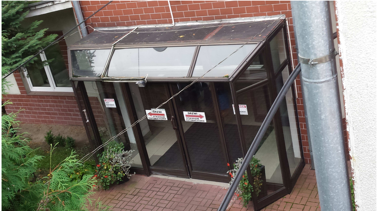
FOT.NR 1 – ISTNIEJĄCA ZABUDOWA WEJŚCIA /DO ROZBIÓRKI/
